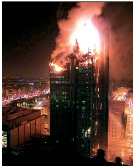
Imagen del incendio del Windsor el 12 de febrero de 2005.
